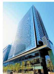
JPタワー名古屋 （2015年11月竣工）
