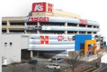
長野商業施設
