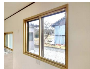
内窓の設置事例
