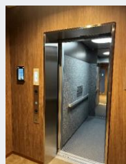
エレベーター
