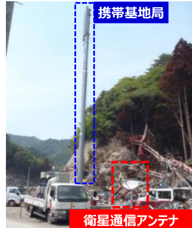
災害現場の携帯移動基地局
