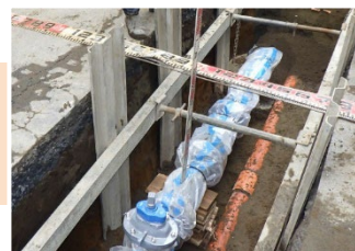
上水道入替工事
