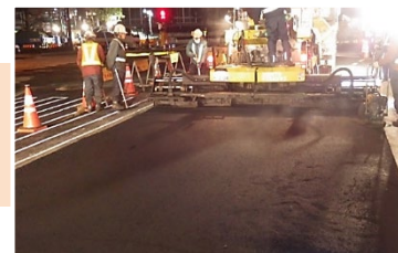
道路舗装工事
