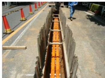
管路地中埋設工事
