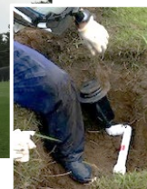
ゴルフ場コース スプリンクラー取替工事
