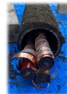
撤去ケーブル
