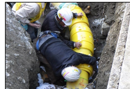
地盤沈下対策&液状化対策として 採用した大口径のPE管敷設作業
