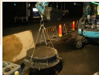
マンホール高さ調整工事
