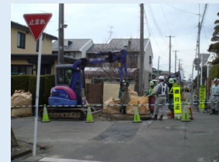
東日本大震災 導管復旧工事
