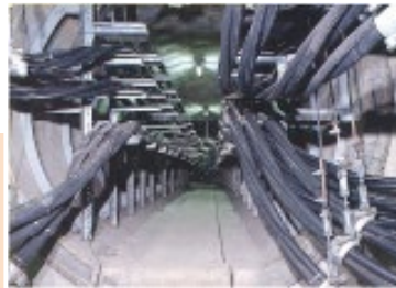
洞道地中建設工事
