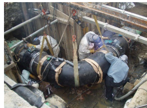
大口径導管溶接工事
