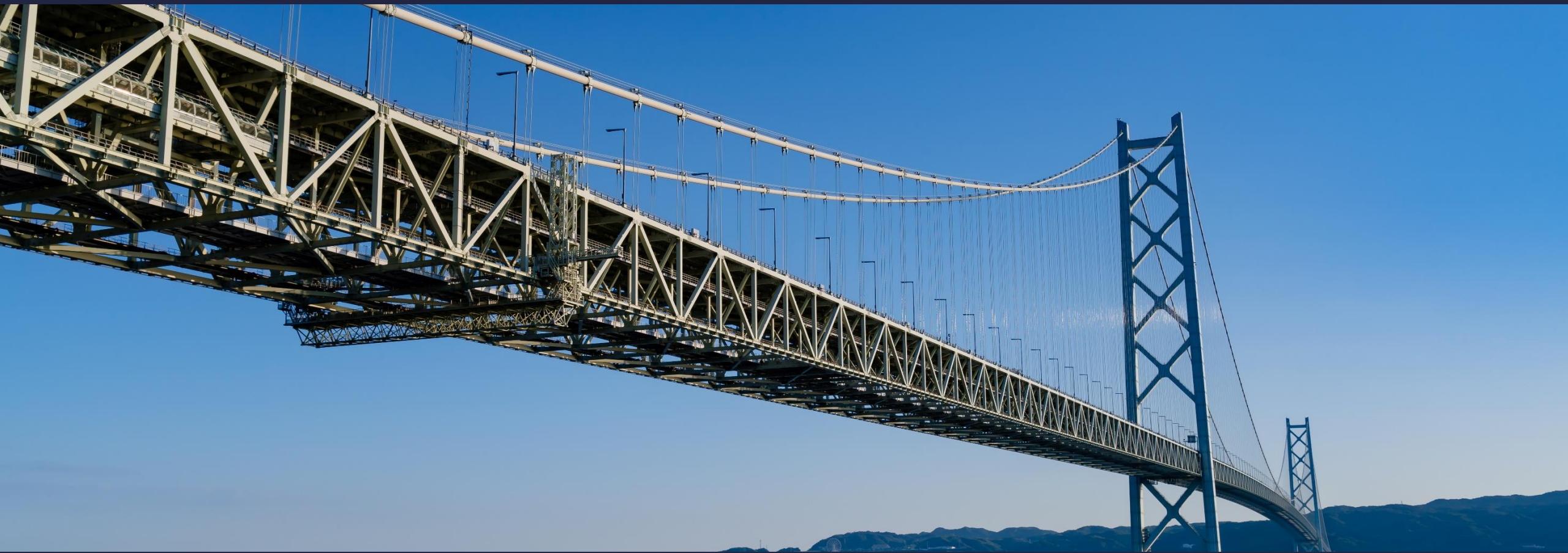
明石海峡大橋
