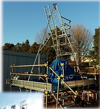
ボーリング 作業構台の 点検
