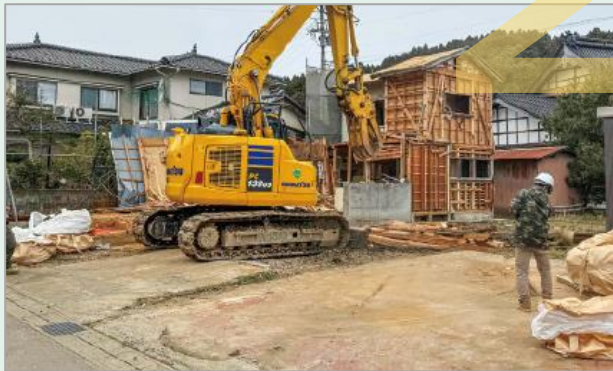
解体進捗管理
