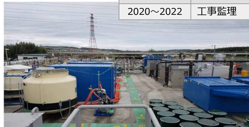
VOC等対策状況（原位置熱脱着工法）
