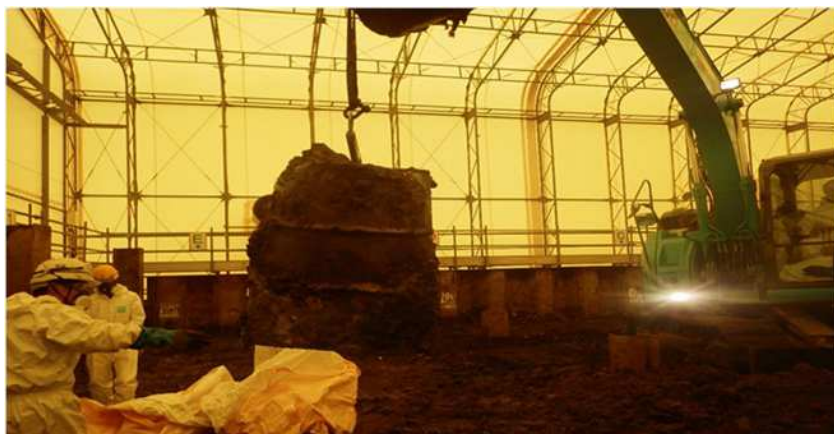
掘削除去の状況（PCB高濃度箇所）
