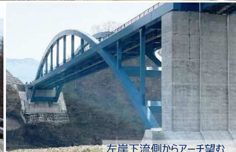
左岸下流側からアーチ望む
