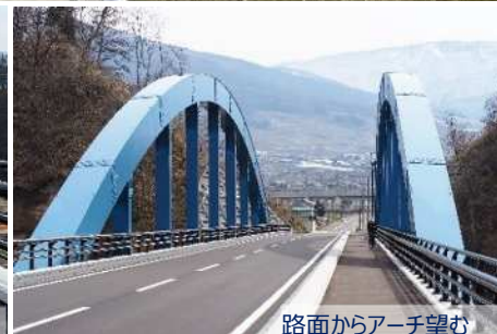
路面からアーチ望む
