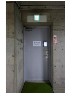
地下駐車場出入口
