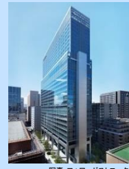
写真: フォワードストローク アーバンネット 内幸町ビル 延床面積: 36,145.48㎡
