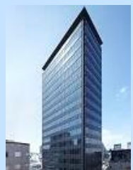
写真: フォワードストローク アーバンネット 神田ビル 延床面積: 14,724.77㎡
