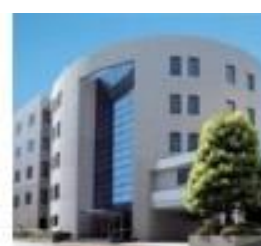
アーバンネット 市ヶ谷ビル
