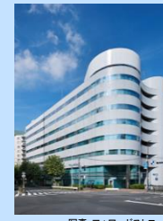
写真: フォワードストローク アーバンネット 入船ビル 延床面積: 6,342.71㎡
