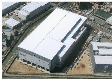
戸田ロジスティクスセンター (埼玉県戸田市)
