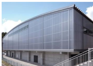
ポリカーボネート樹脂製 高断熱中空パネル 「ルメウォール」
