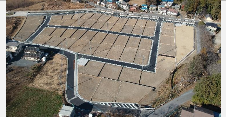
寄居町男衾区画整理事業(埼玉県大里郡寄居町)
