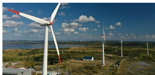
稚内風力発電所
