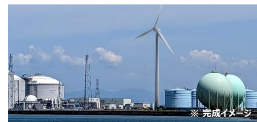
北ガス石狩風力発電所 (2024年9月完成予定)
