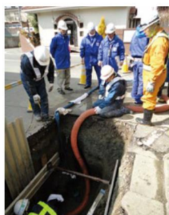
ガス導管の修繕作業 (仙台市)
