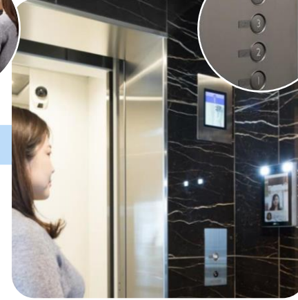
エレベーター
