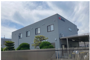
丸亀工場厚生棟
