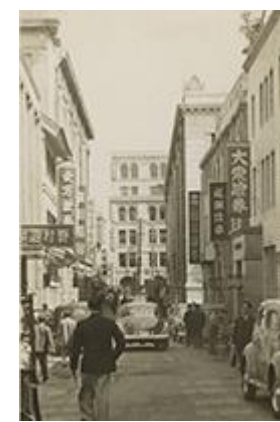
兜町の街並み（昭和中期） 写真提供：中央区立京橋図書館
