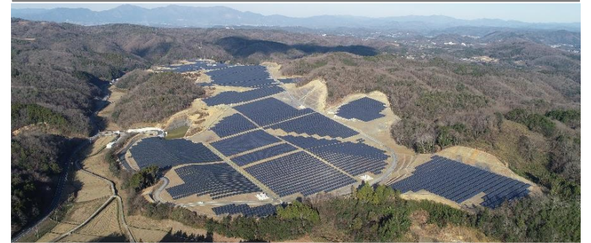
FBIT美咲発電所 (岡山県久米郡美咲町)
