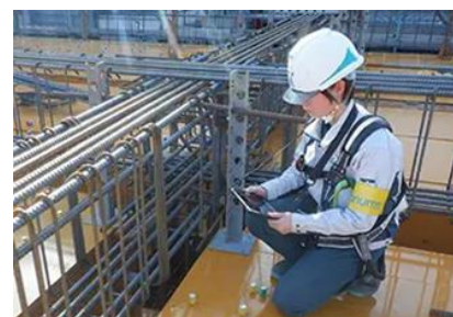
タブレットで配筋を検査
