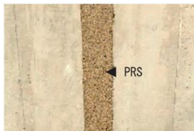
PRS目地充填状況
