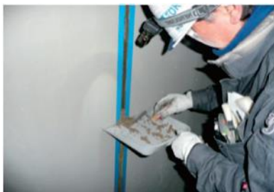
PRS目地充填工法施工状況
