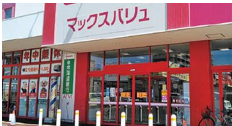
ガードバリカー（衝突防止）の設置
