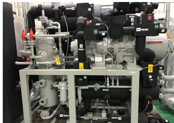
アンモニアの気化熱によりCO2を冷却しレシーバー部へ格納 配管から各定温倉庫へCO2を充填冷却
