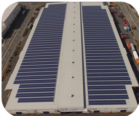
名古屋港流通センター営業所
