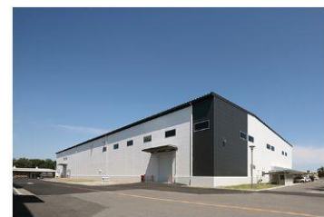
2022年 滋賀工場 塗装棟稼働
