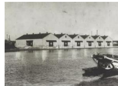
昭和初期竣工当時
