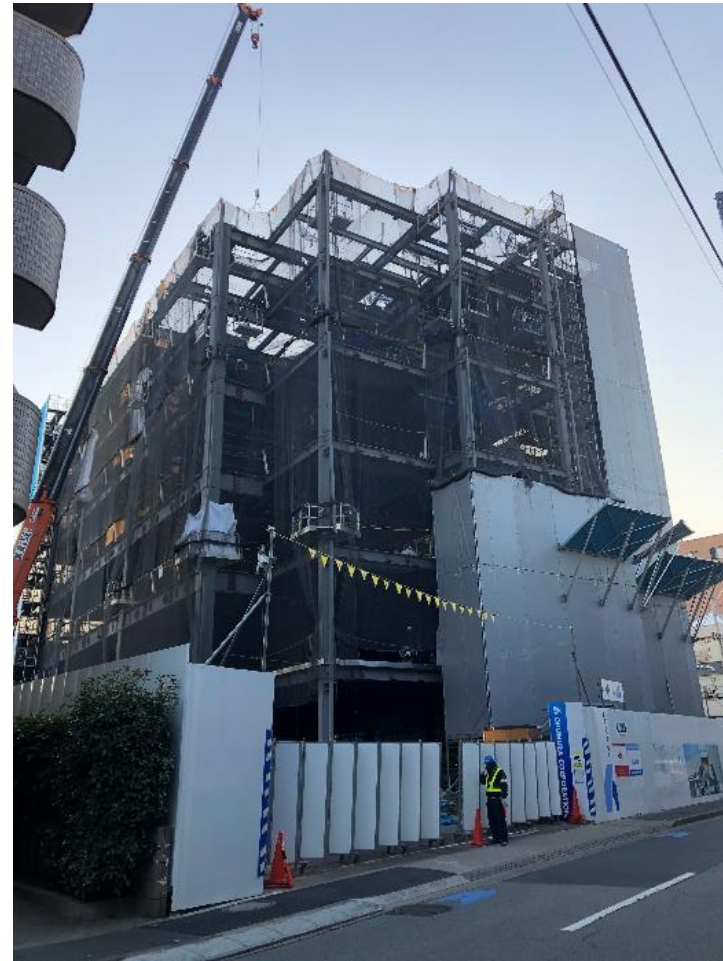
鉄骨工事 校舎
