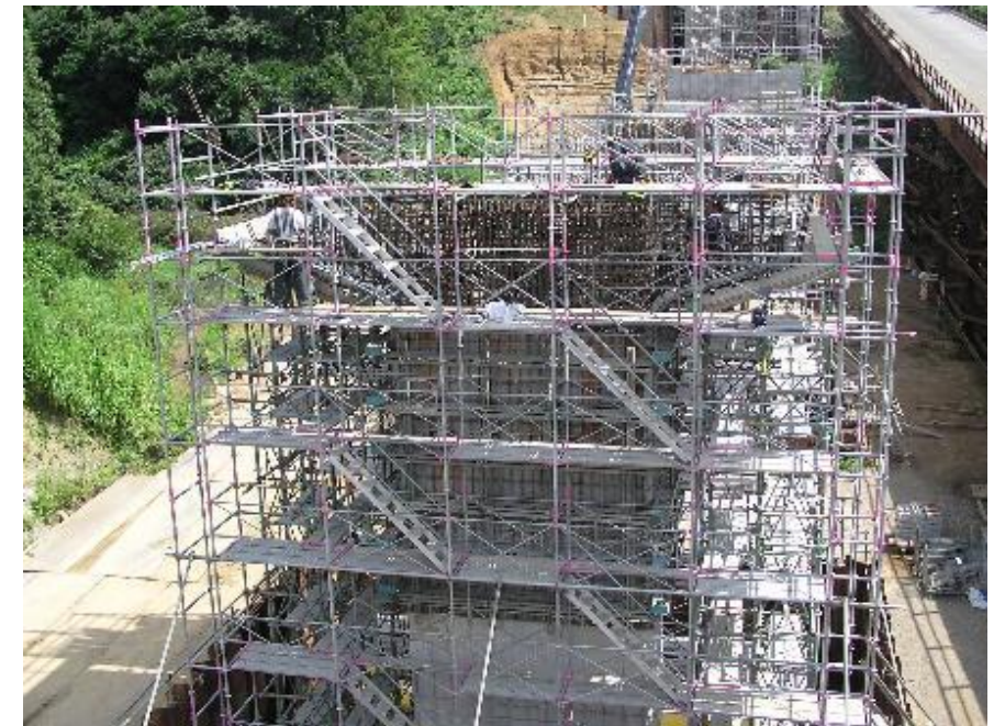
型枠工事 橋梁
