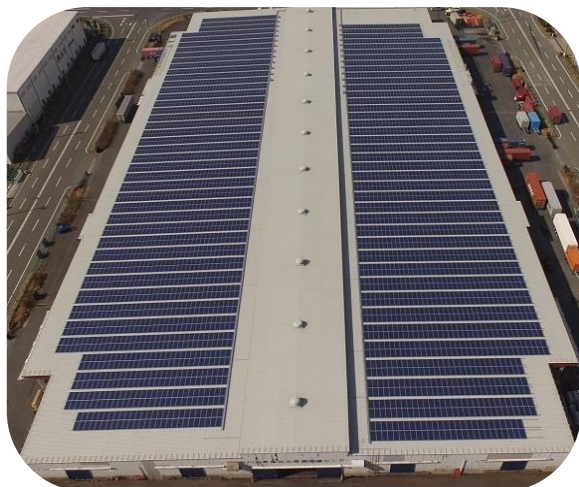
名古屋港流通センター営業所
