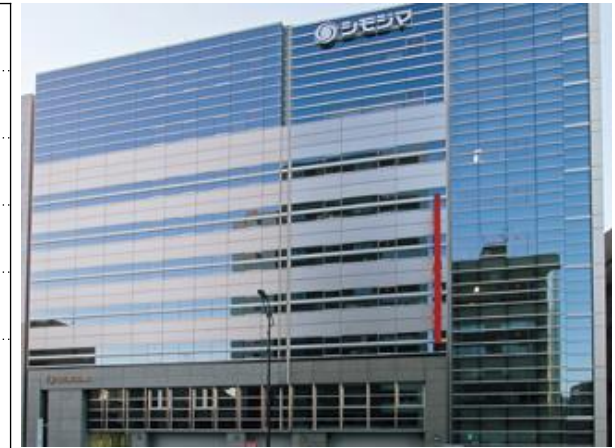
シモジマ本社ビル
