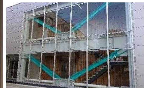
②増築棟 制震ダンパー
