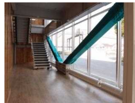
②増築棟 制震ダンパー
