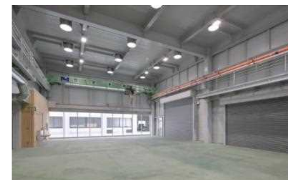
③増築棟 多目的実験スペース
