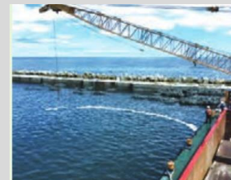
起重機船による回収
