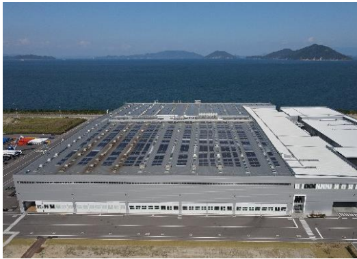
香西工場屋上の 太陽光発電設備
