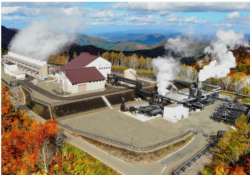
山葵沢地熱発電所 (秋田県) 事業主体：湯沢地熱(株) 2019年5月運転開始 出力：46,199kW
