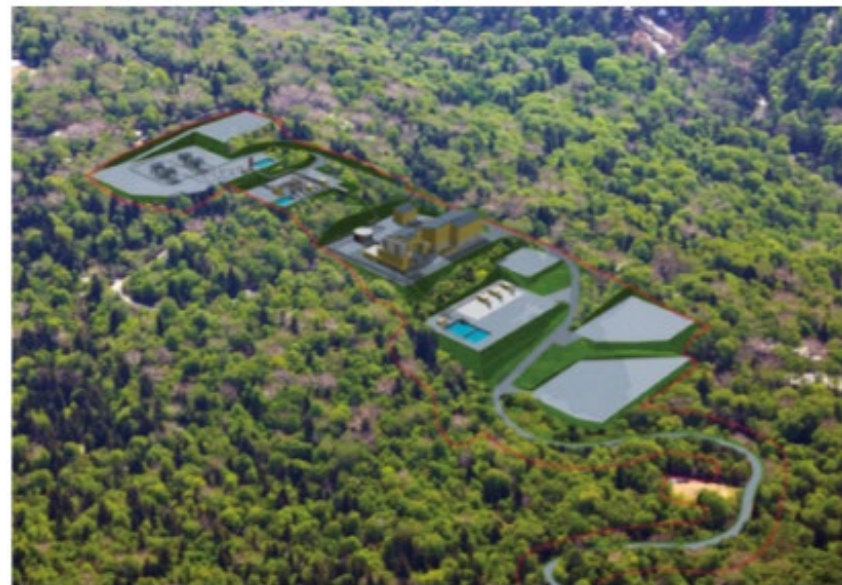
安比地熱発電所 (岩手県、建設中) 事業主体：安比地熱(株) 2024年4月運転開始予定 出力：14,900kW
