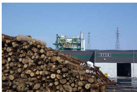
バイオマス発電（山形県米沢市）
