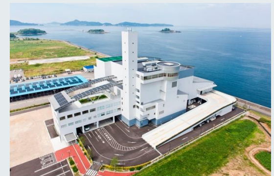
ごみ焼却発電設備
