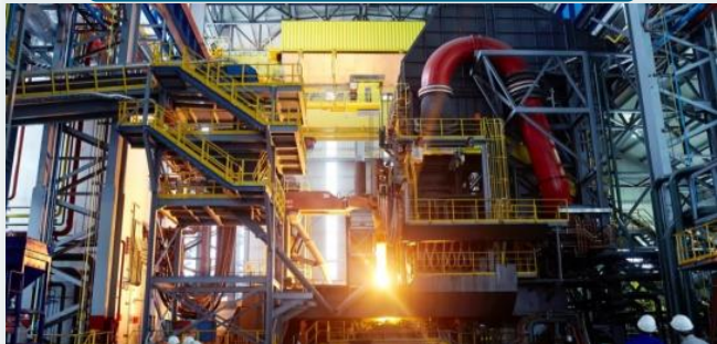
製鉄機械（新型電気炉）
