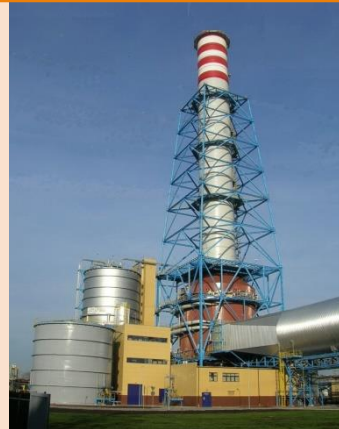
排煙脱硫装置
