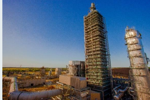
CO 2 回収プラント
