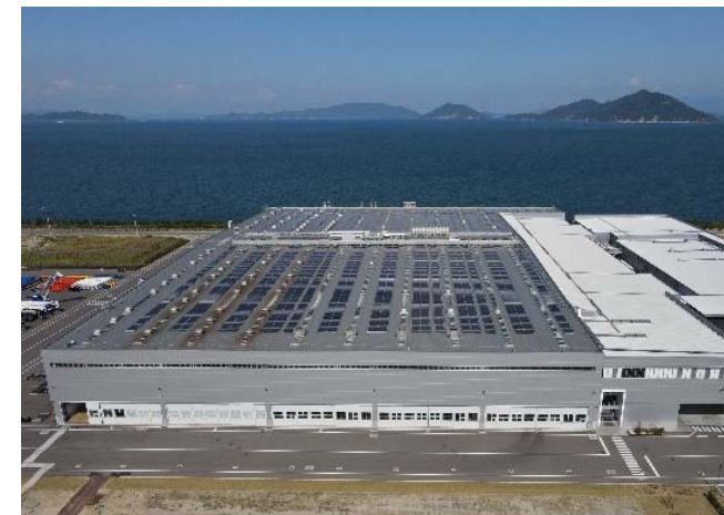
香西工場の太陽光発電設備
