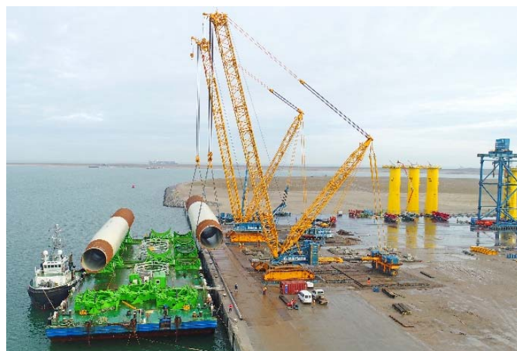
港湾で風車の部材積込を行うCC
