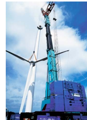
陸上で風車のブレード据付を行うAT
