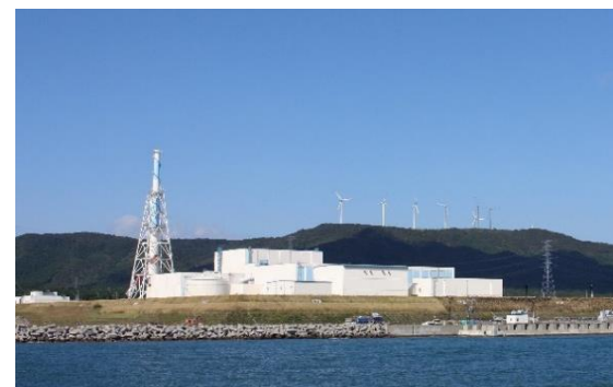
東通原子力発電所（全景）
