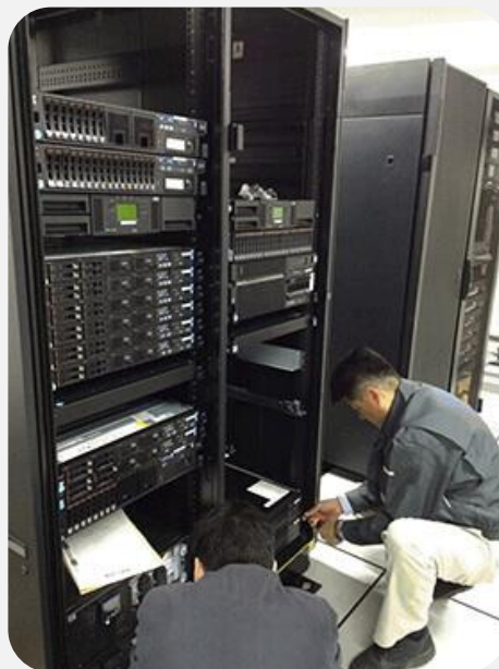
サーバー移設・配送・設置
