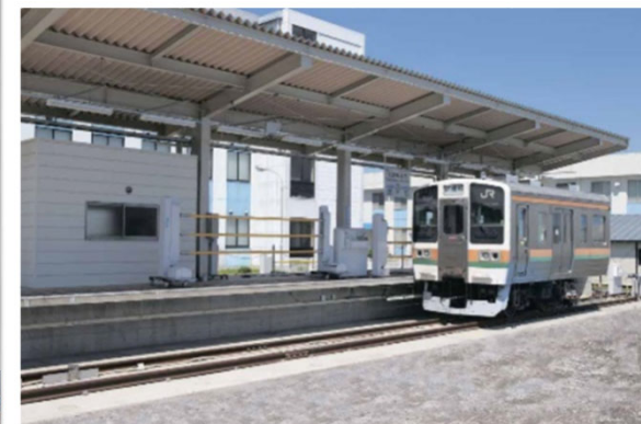
＜ホームドア試験設備＞
