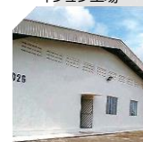
インドネシア・ビンタン工場
