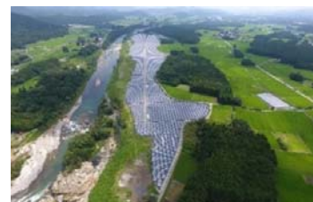
太陽光発電所 (栃木県日光市)
