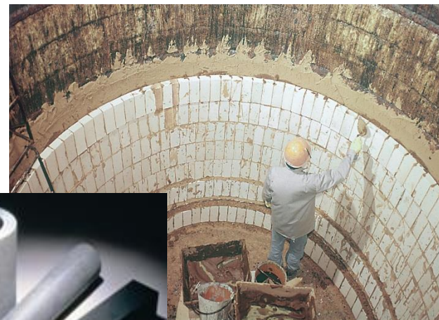
耐火れんがの築炉
