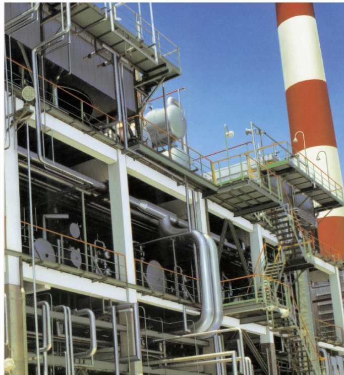
プラント鉄骨架台の耐火被覆
