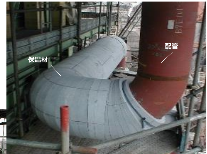
保温材取付け (施工中)
