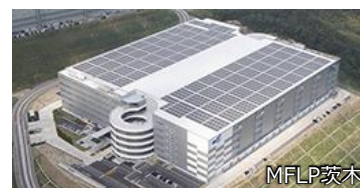
太陽光パネル
