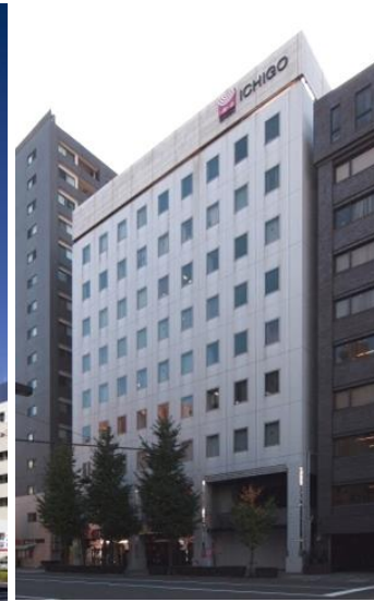
O-64 いちご桜橋ビル
