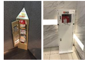
ELV内防災キャビネット、AED
