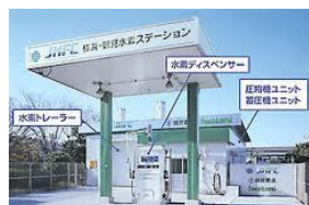
水素ステーション
