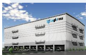
(仮称) ロジクロス船橋 (23千㎡) 2021年竣工予定
