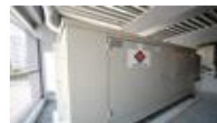
非常用発電設備の設置
