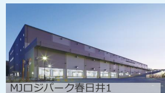
MJロジパーク春日井1
