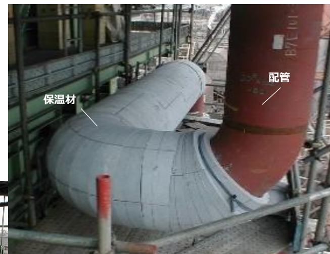
保温材取付け (施工中)
