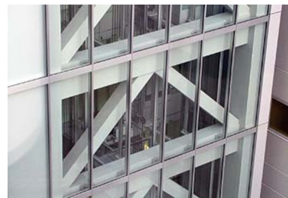
EVシャフト・ブレースの耐火被覆（複合ビル）
