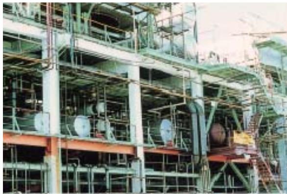
プラント架構の耐火被覆
