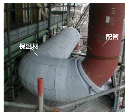
保温材取付け (施工中)
