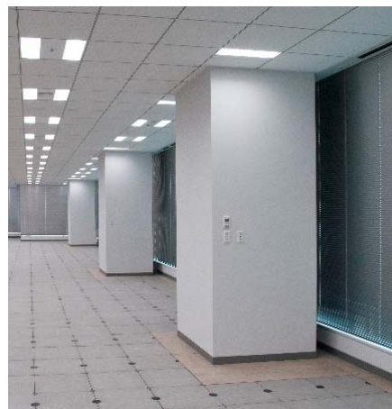
柱の耐火被覆（オフィス）
