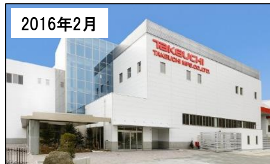
本社・第3工場 竣工 (約30億円)
