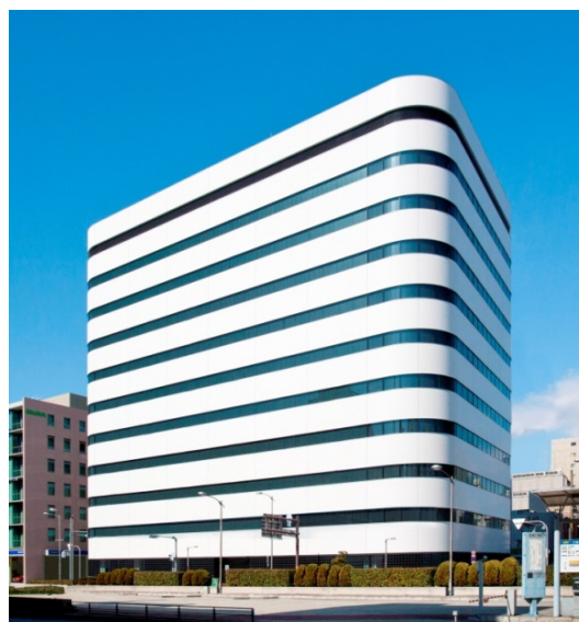
西心斎橋ビル
