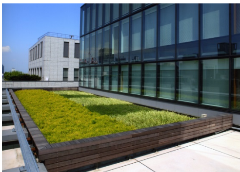
御堂筋ビル屋上緑化
