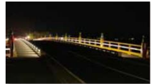
LED歩道照明
