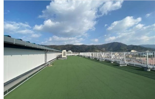
地震の発生や河川の氾濫等に備えた屋上避難エリア。200名を収容可能。
